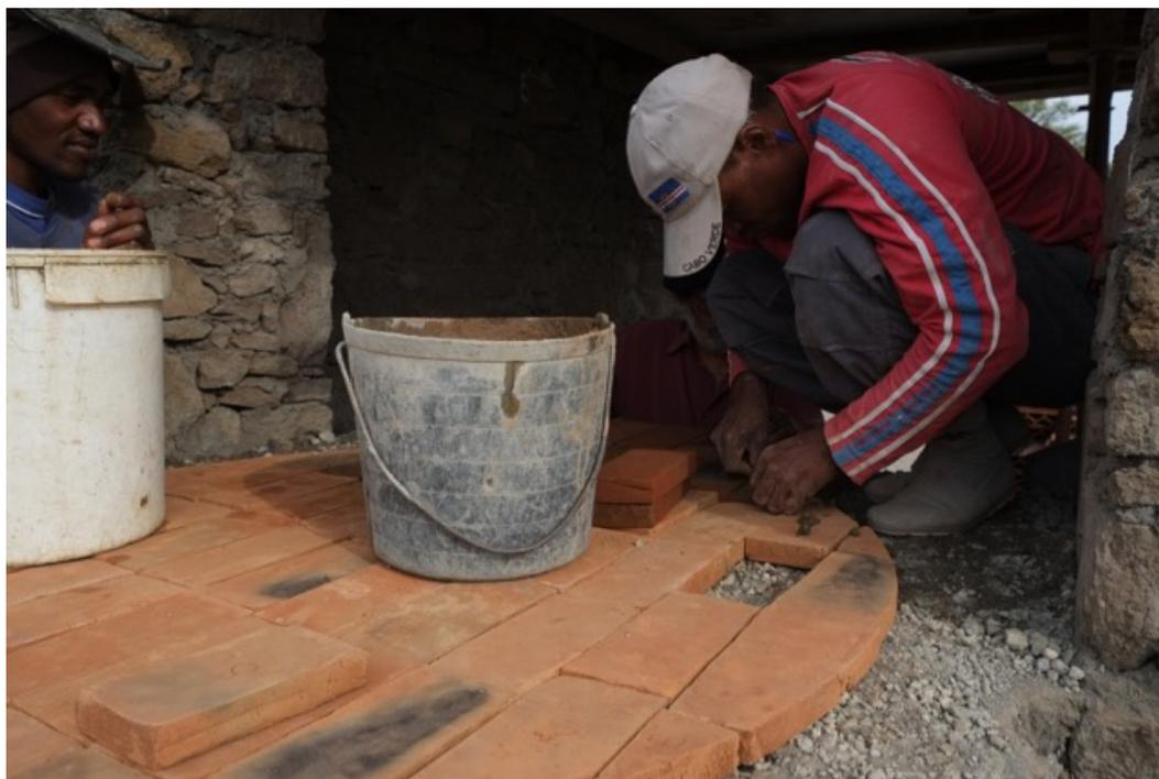
A construção do forno decorreu em duas fase. Numa primeira fase o forno foi construído em cerâmica e cozido no M\_EIA com o envolvimento dos alunos. Na segunda fase foi montada no Planalto onde recebeu duas outras camadas de materiais, uma mistura de pozolana com barro e uma segunda camada de argamassa.
