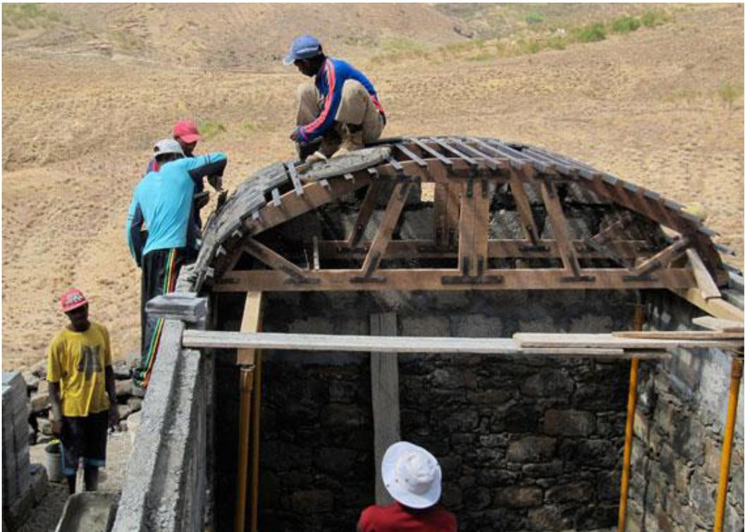
A tecnologia de cobertura utilizada para a construção da cisterna de 420 toneladas de capacidade sendo transferida para a cobertura de uma habitação.
