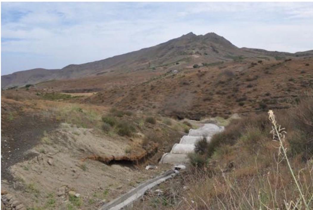
Um conjunto de cisternas construídas no leito de uma ribeira com capacidade para 420 Toneladas de água. A construção de uma outra cisterna com a mesma capacidade, e num bom ano de chuva, poderia resolver o problema de consumo de água para os animais da comunidade.
